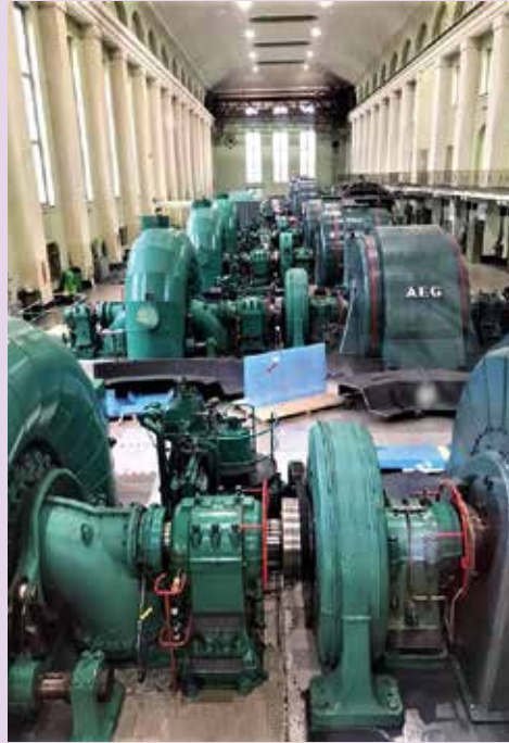
DAS WALCHENSEEKRAFTWERK NUTZT ZUR STROMERZEUGUNG DAS NATÜRLICHE GEFÄLLE VON 200 METERN ZWISCHEN WALCHENSEE UND KOCHELSEE. ES GEHÖRT DER UNIPER KRAFTWERKE GMBH. FOTOS: ANJA KNÄPPER
