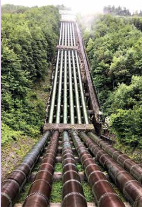
DAS WALCHENSEEKRAFTWERK NUTZT ZUR STROMERZEUGUNG DAS NATÜRLICHE GEFÄLLE VON 200 METERN ZWISCHEN WALCHENSEE UND KOCHELSEE. ES GEHÖRT DER UNIPER KRAFTWERKE GMBH. FOTOS: ANJA KNÄPPER
